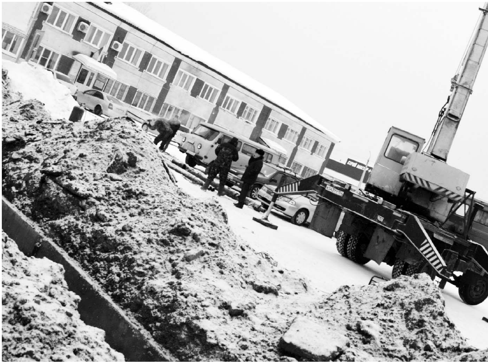
28 часов без перерыва МУП "Теплоцентральный" работало на порыве теплотрассы в Панкрушихе.
