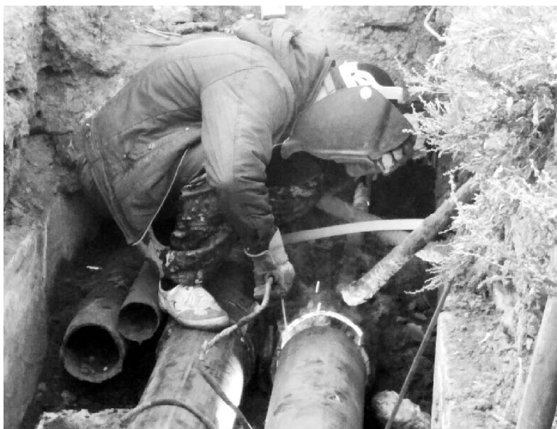
Особые, как их называют, "хирургические" швы на трубах требуют внимательного подхода и большой аккуратности в исполнении.
