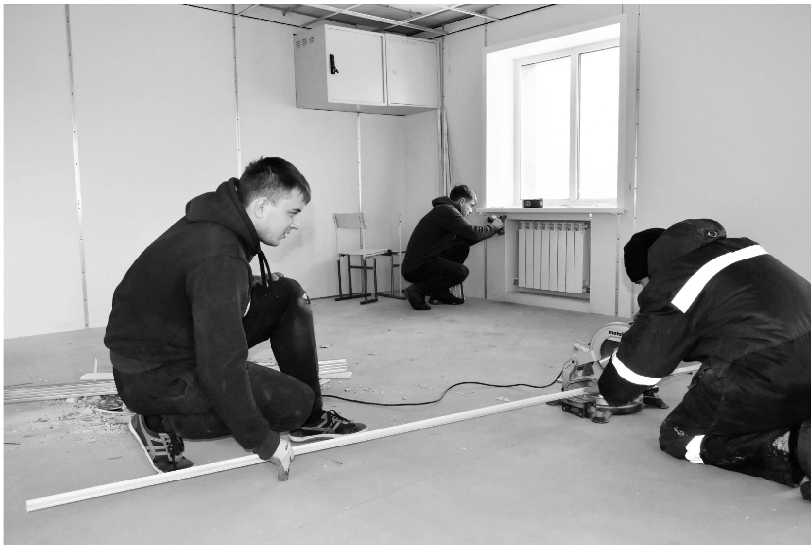
Строителями завершается отделка внутренних стен в аудиториях обоих корпусов.
